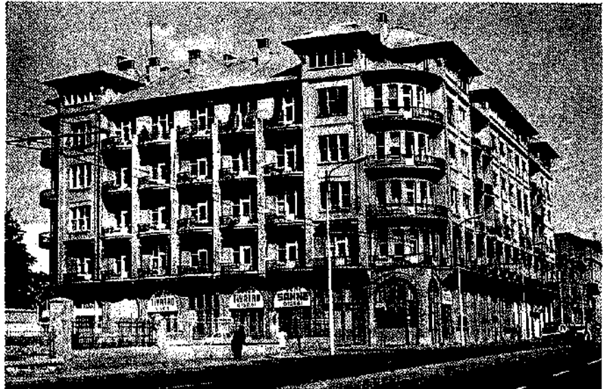
Şekil 31. Ankara-İkinci Vakıf Hanı (bugünkü Devlet Tiyatrosu Genel Müdürlüğü). Yapım yılı: 1928. Batı'dan görünüşü. (Ekim 1973, Y.Yavuz.)
