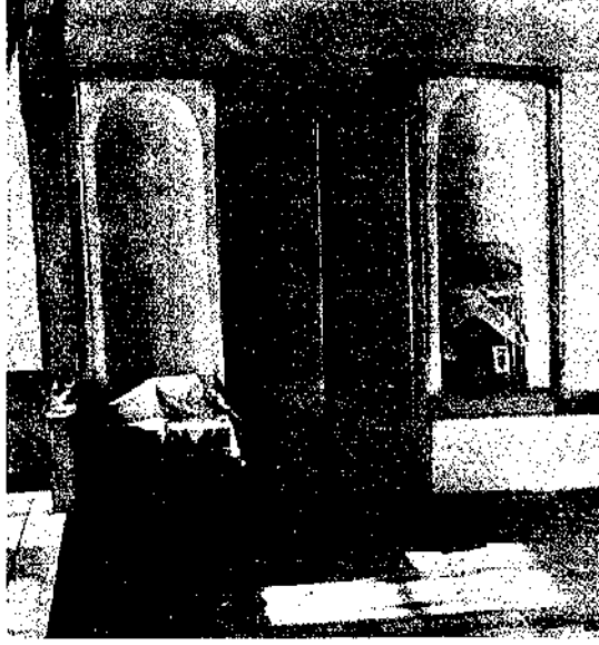
Şekil 52. Muharremoğlu Evi Birinci Kat Merdiven Karşısındaki Oda Kapısının İki Yanındaki Nişlerin Görünüşü.
