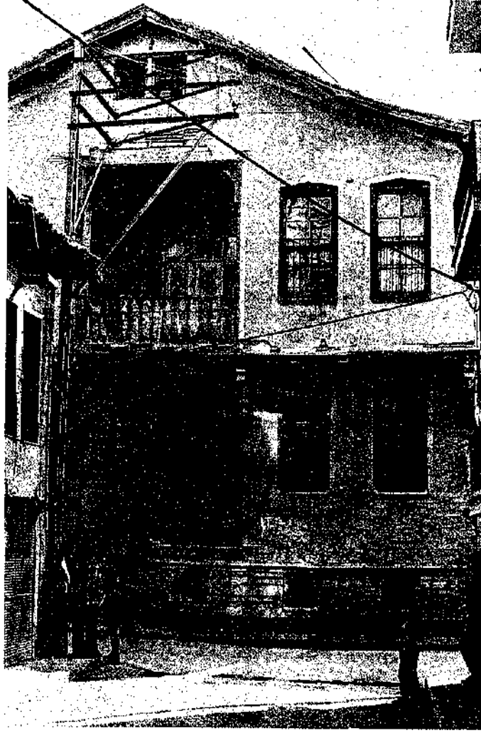
Şekil 33. Serficeli Osman Anadolu Evi Giriş Cephesinden Ayrıntı.
