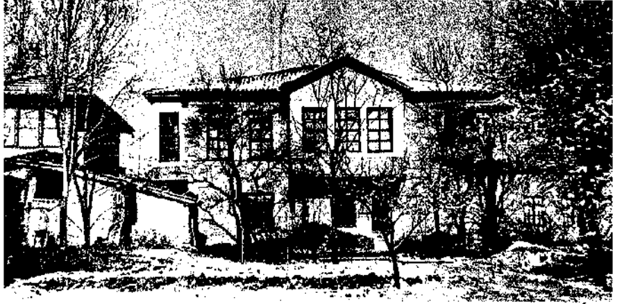
Şekil 61. Muharremoğlu Evinin Güneyden Görünüşü.
