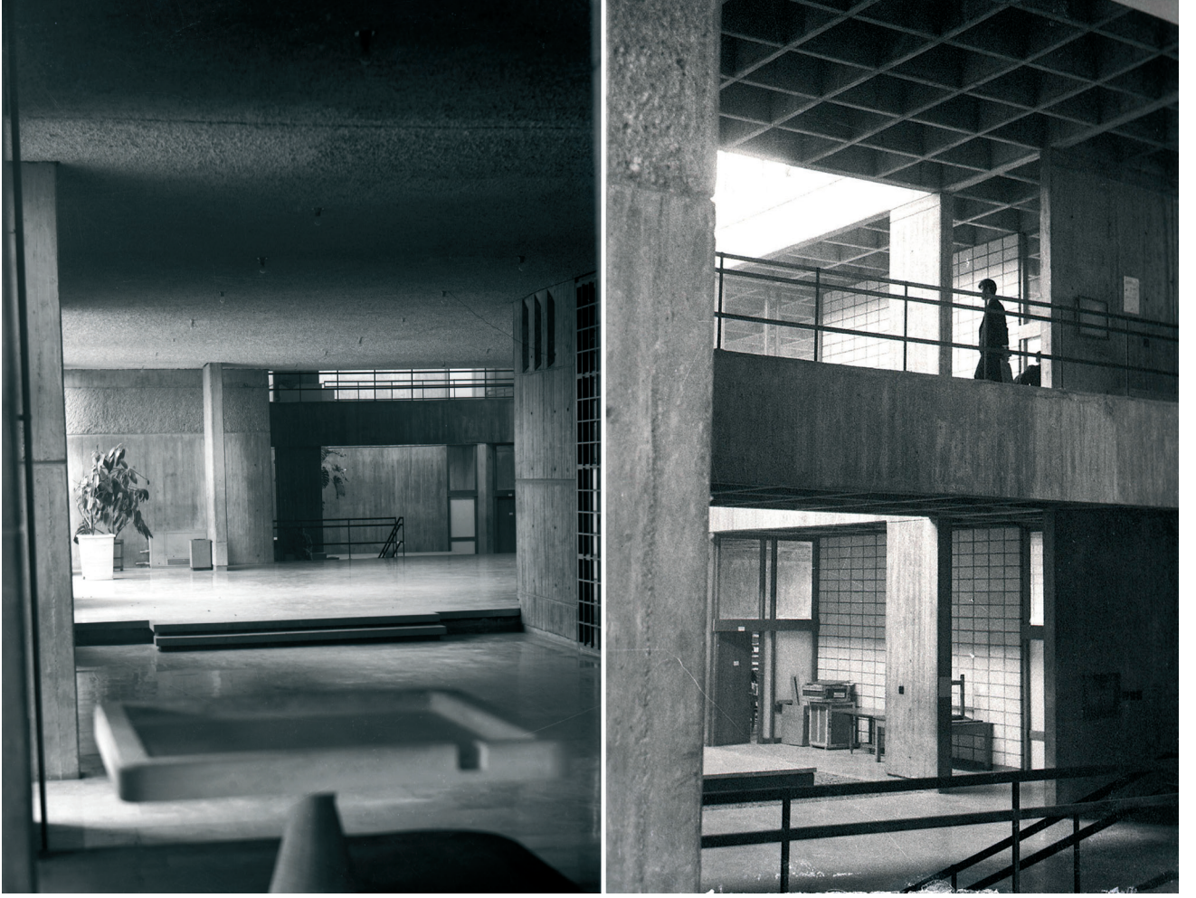
Resim 4. F Blok +375 kotu döşeme kaset hizasında duvarın G3 giriş mekanına cephe veren yüzünde meydana gelen doku farklılaşması (Salt Araştırma, Altuğ-Behruz Çinici Arşivi)
