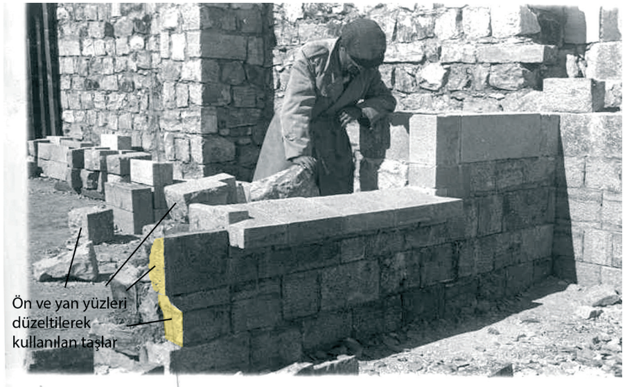
Resim 8. Maraş Halkevi inşaatında yerli ustalar tarafından taş duvar örülmesi (490-1-0-0, 1763-1156-1, 72).
