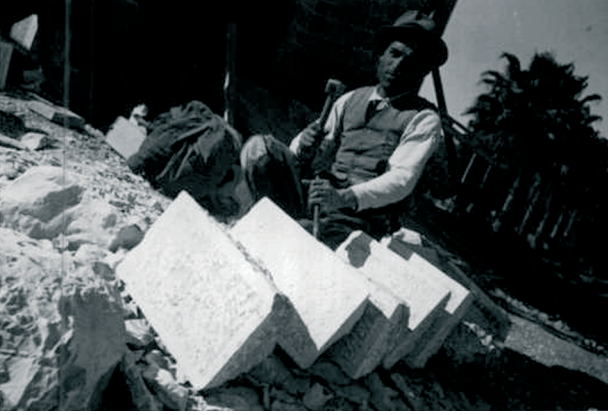
Resim 9. Geleneksel yöntemlerle taşı şekillendiren bir usta (490-1-0-0, 1763-1156-1, 16).
