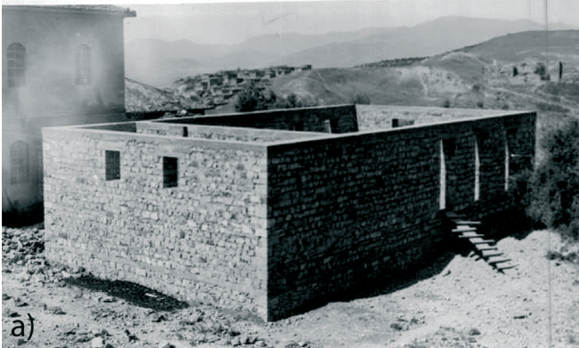
Resim 17. Kütüphane binası a) 1946 yılında beden duvarları tamamlanmış vaziyette (490-1-0-0, 1763-1156-1, 66) b) İnşaat bitiminde (490-1-0-0, 1763-1156-1, 74).
