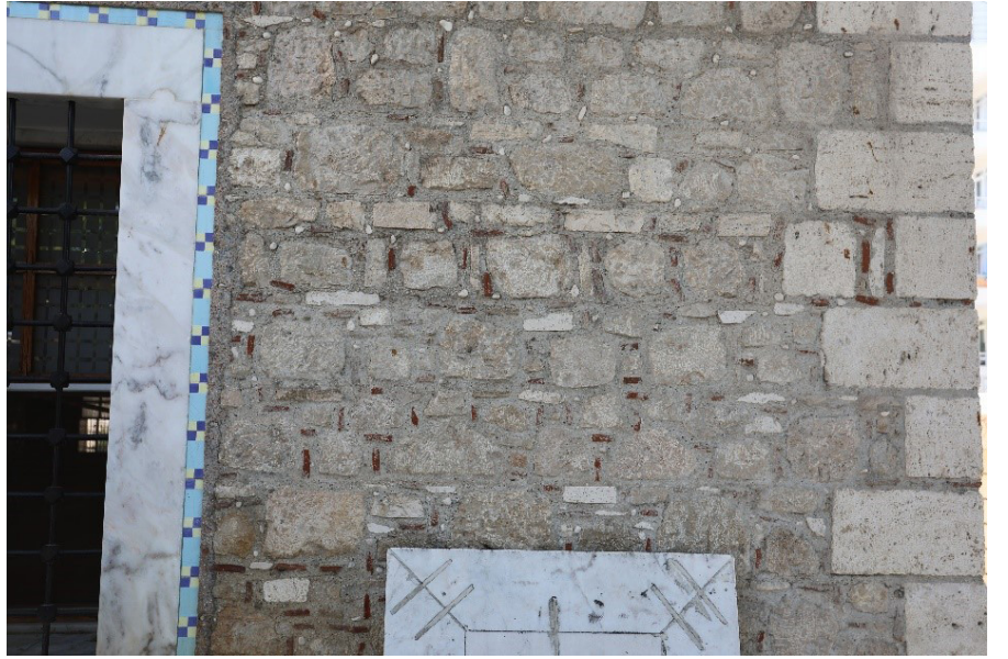
Resim 21. Karakaş Camii düzensiz çerçevesi teknikte örülmüş duvar detayı
