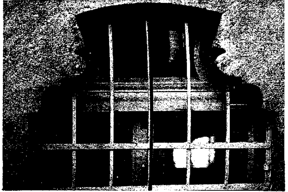
Şekil 3. Konya Öğretmen Lisesi Bodrum Kat Pencerelelerinden Ayrıntı.
