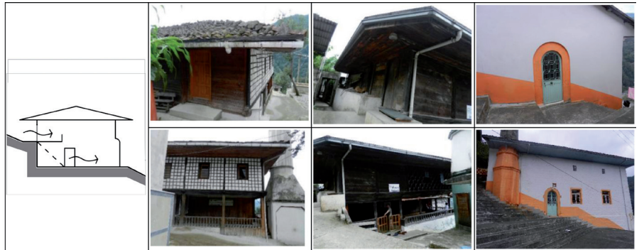
Resim 9. Mahfil katına doğrudan girişin sağlandığı Günebakan Köyü ile Güney Mahallesi ve Gündoğan Yeşil Mahallesi Camileri
