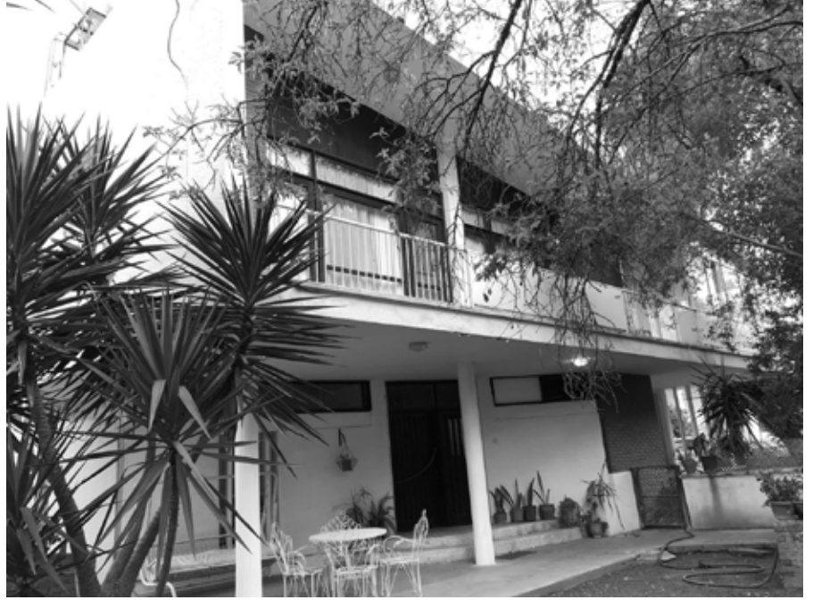
Resim 13. Giriş cephesi (Meray Taluğ'un arşivi)
