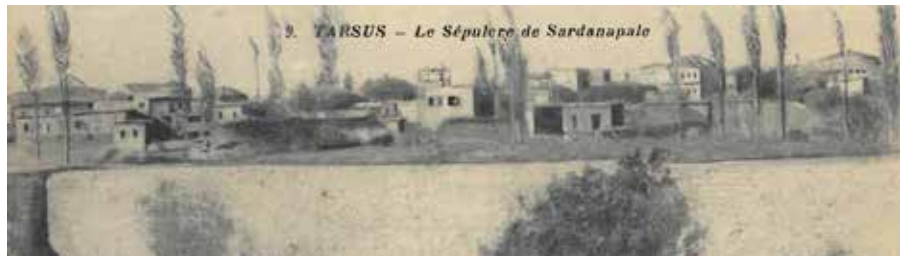
Resim 1. Donuktaş'tan bakışı gösteren eski bir fotoğrafta yer alan tek katlı yapılar ve fotoğrafın ortasında görünen ahşap çatkı yapı (yazar arşivi)
