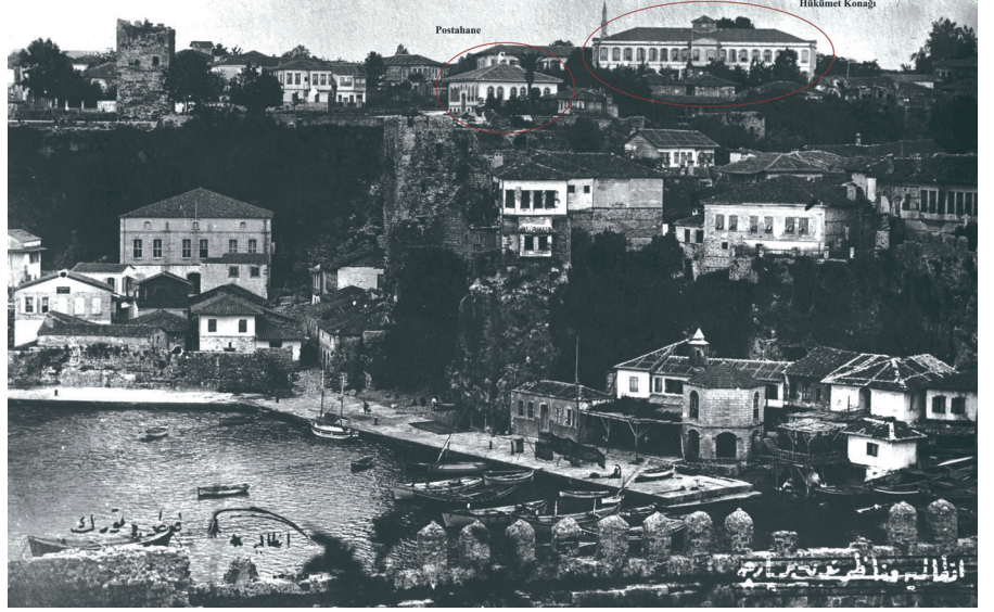
Resim 7. İç kalenin bulunduğu alanı koruyan sur duvarlarının 1914'te yıkılmasından sonra Hükümet Konağı kent manzarasına bütünüyle hâkim oldu (Basın Yayın ve Enformasyon Genel Müdürlüğü Arşivi).
