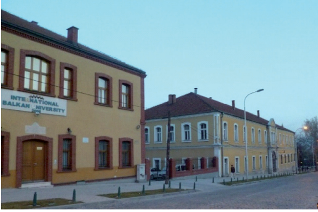
Resim 17. Yönetmel ve askeri merkezindeki yapılardan günümüze kalan Postane ve Vali Konağı'nın yapılarının görünümü (Bektaş G., 2012)
