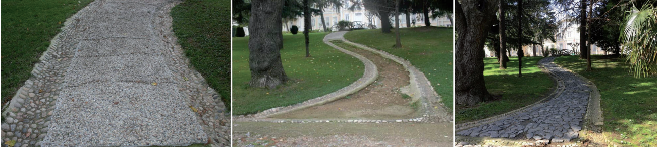
Resim 5. Solda Yıldız Sarayı Şale Köşkü bahçelerindeki iri agregatlar ile hazırlanmış yağmur oluklu yer döşemesinin özgün hali (İzgi, 2011; 45), ortada aynı yer döşemesinin onarım öncesi durumu (İzgi, 2011,45), sağda aynı yer döşemesinin onarım sonrası durumu. Eski döşemeye ait iri çakıl taşları ile hazırlanmış yağmur olukları korunmuş fakat kayrak taşları ile yapılan yeni düzenleme eskisiyle uyumsuz bir görüntü oluşturmuştur.
