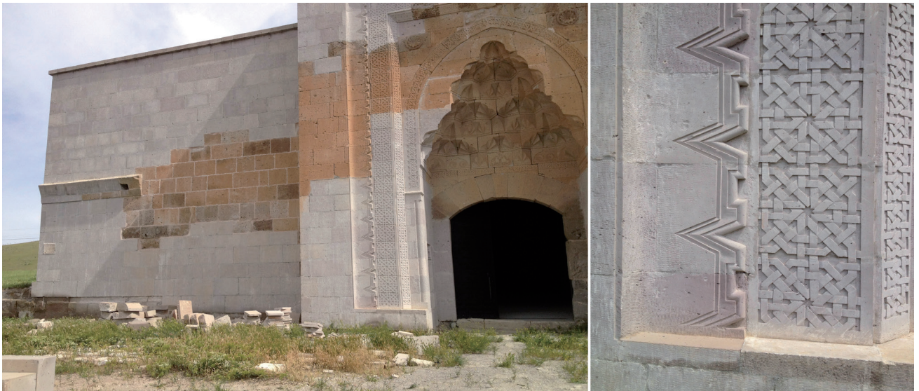
Resim 17. Alay Han’ın 2009-11 Yılları Arasında Gerçekleştirilen Onarımının Rekonstrüksiyona Varan Bütünleme Uygulamasında Yeniden Yapılan Taçkapıdaki Bezemeler (G. Tanyeli kişisel arşivi, 2013)
