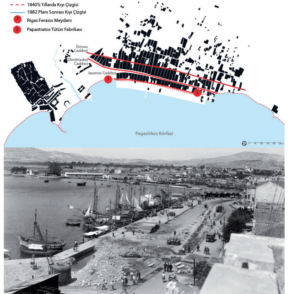
Resim 7. 1882 planı sonrası yapılan dolgu (Municipal Center for Historical Research and Documentation Center, Volos).
