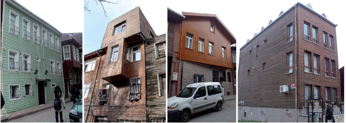
Resim 23. Kültür varlığı olarak tescilli olan 1007 ada 1 parseldeki yapının geçirdiği restorasyon süreci ve sonrasında görünüşler (Koray Güler Kişisel Fotoğraf Arşivi, 2015).
