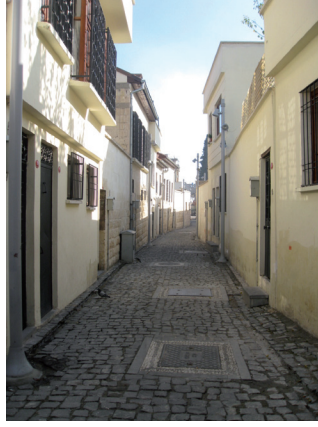
Resim 9. Ubeydullah Sokak'ta sağlıklaştırma çalışmaları kapsamında korunmuş livas sistemine ait baca ağzları (dikdörtgen kapaklar) (2014)
