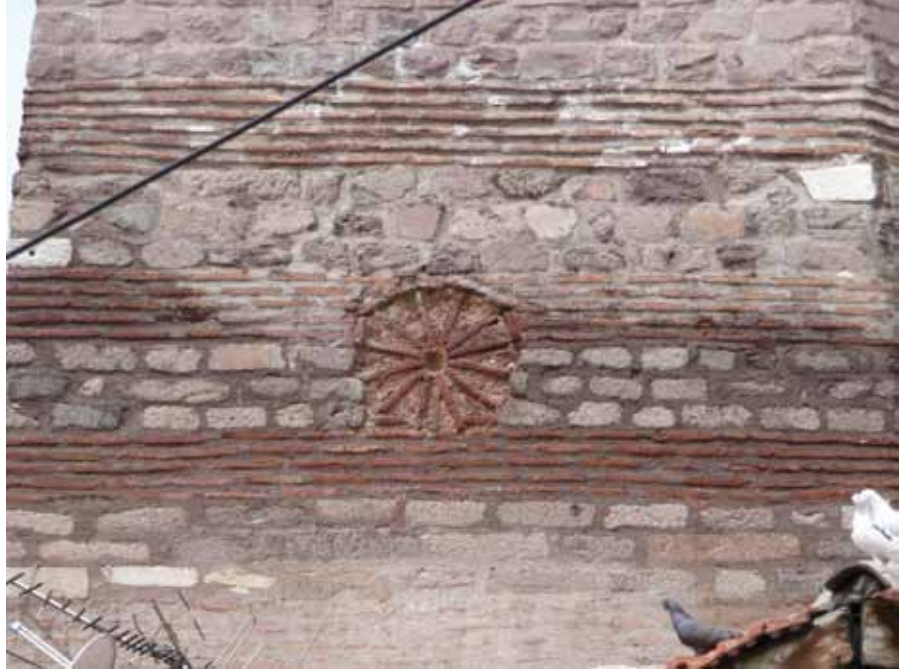
Resim 10. Ankara Kalesi, İç Sur, dönüşümlü tuğla ve moloz taş (almasıık) duvar tekniği, 2008 (Ufuk Serin).
