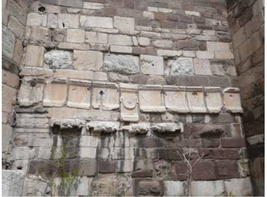
Resim 16. Ankara Kalesi, İç Sur, Güney Kule, tümüyle devşirme malzeme ile inşa edilen dış cephe, 2008 (Ufuk Serin).
