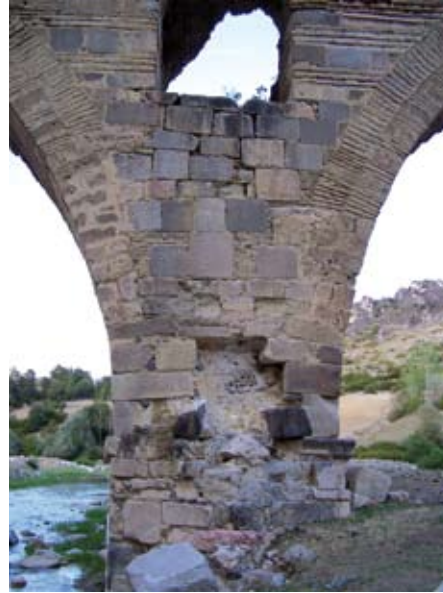
Resim 8. Orta Ayaktaki Selyaran ve devşirme malzeme kullanımı.
