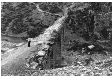
Resim 10.11. Tarihi Kurt Köprüsü Mansap Cephesi ve Döşeme Üzerinden Görünüm, 1969. (KGM Tarihi Köprüler Şubesi Arşivi)
