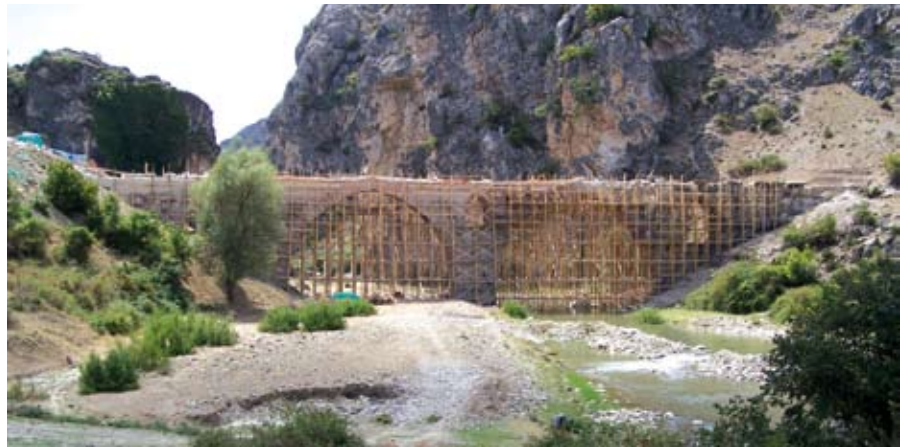
Resim 18. İş iskelesinin kurulması, Mansap Cephesi, 2008. (KGM Tarihi Köprüler Şubesi Arşivi).
