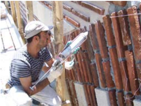
Resim 27, 28, 29. Tuğla imalatta derz yapılması, restorasyon sonrası basamaklı iniş ve mihrap ögesi, 2008. (KGM Tarihi Köprüler Şubesi Arşivi)
