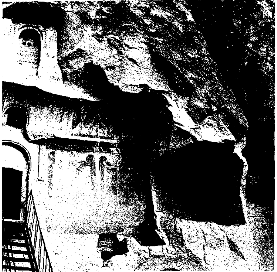
Şekil 22. Nevşehir, Çavuşin'deki Saint Jean kilisesinin Kapadokya yöresine özel koruma ve onarım sorunlarının bazılarını anımsatan görüntüsü.
