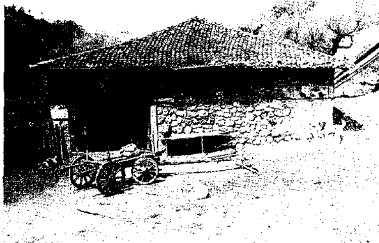
Fig. 12 Gavur'un Değirmeni (Water-mill Number 1) : Lower mill-house.
