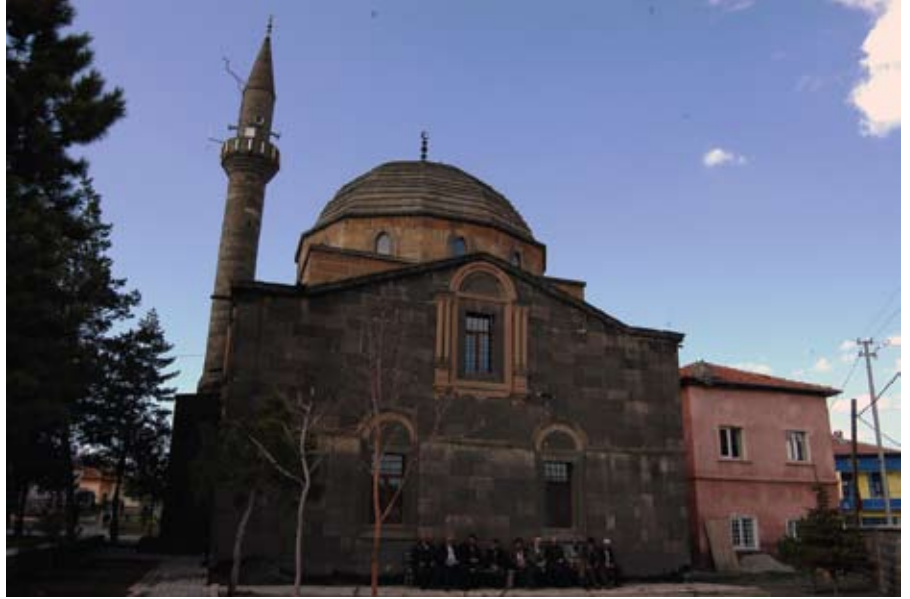
Resim 1. Tomarza Merkez Camisi güney cepheden genel görünüşü.
