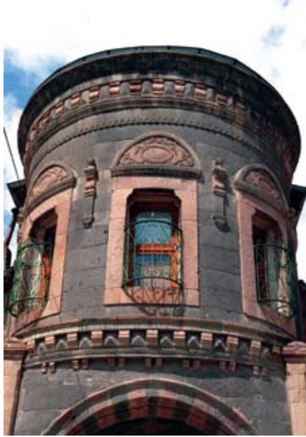
Resim 17. Tomarza Müftülük Binası pencere düzenlemesi.
