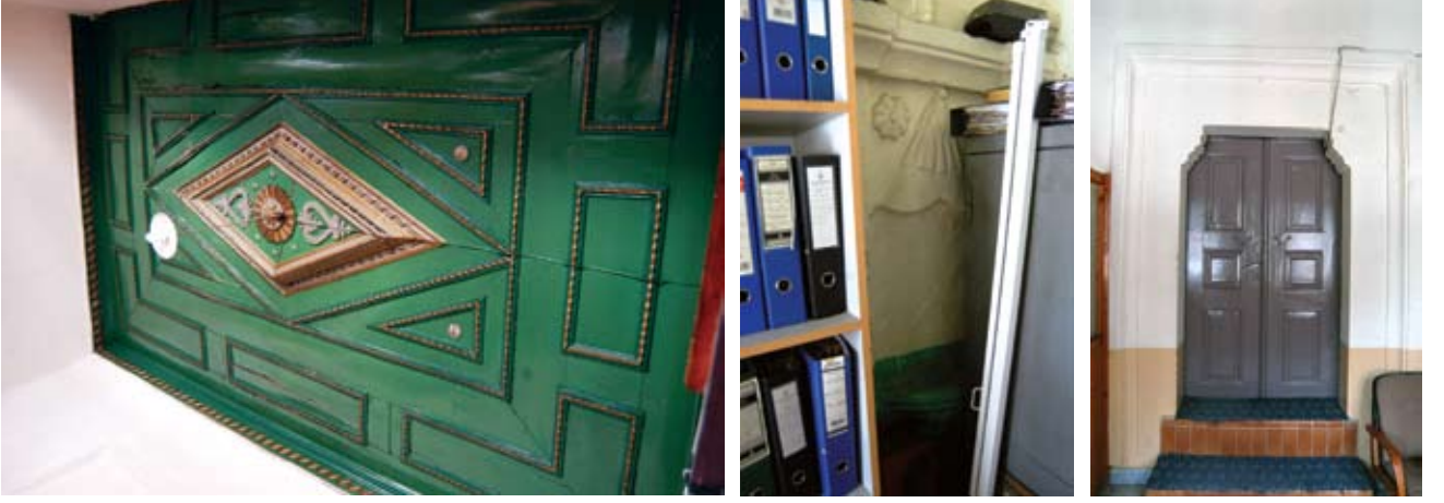
Resim 22. Tomarza Müftülük Binası, üst kat giriş koridoru üst örtüsü.
