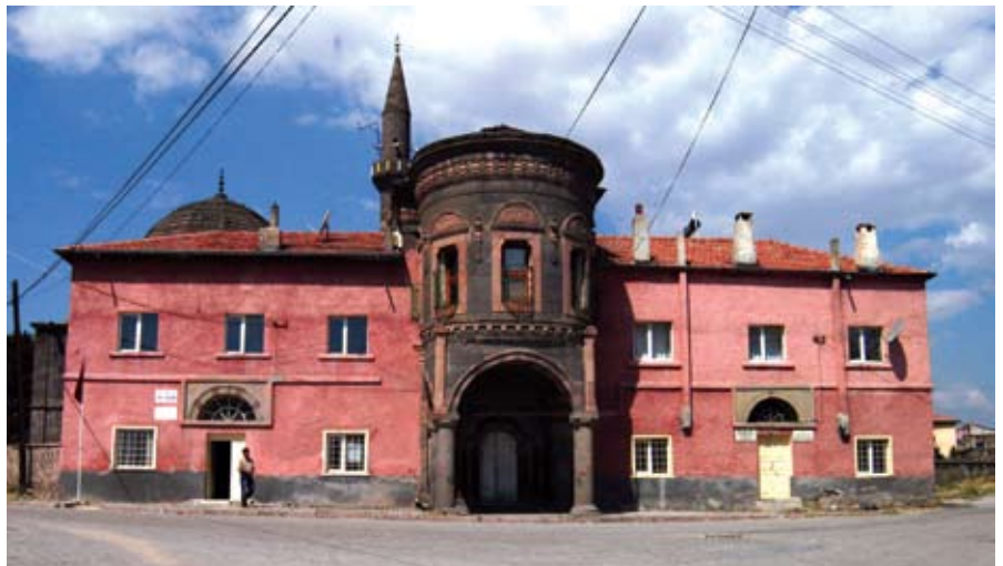
Resim 12. Tomarza Müftülük Binası, genel görünüş.
