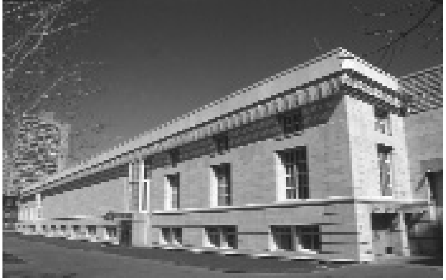
Resim 13. Kuzeydeki ana giriş cephesinin doğudan (kütüphane tarafından) batıya görünümü. Geride giriş holünün pencereleri (A.U. Peker, 2000).
