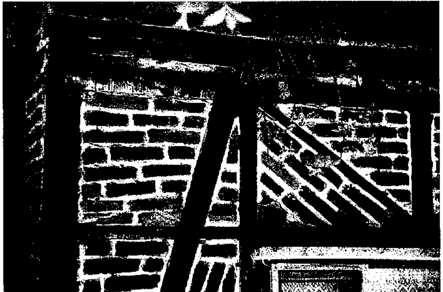
Resim 9. Dolgu duvarlı yapılarda tuğla ile ahşap çerçeve arasında hiç bir yapısal bağ bulunmamaktadır.
