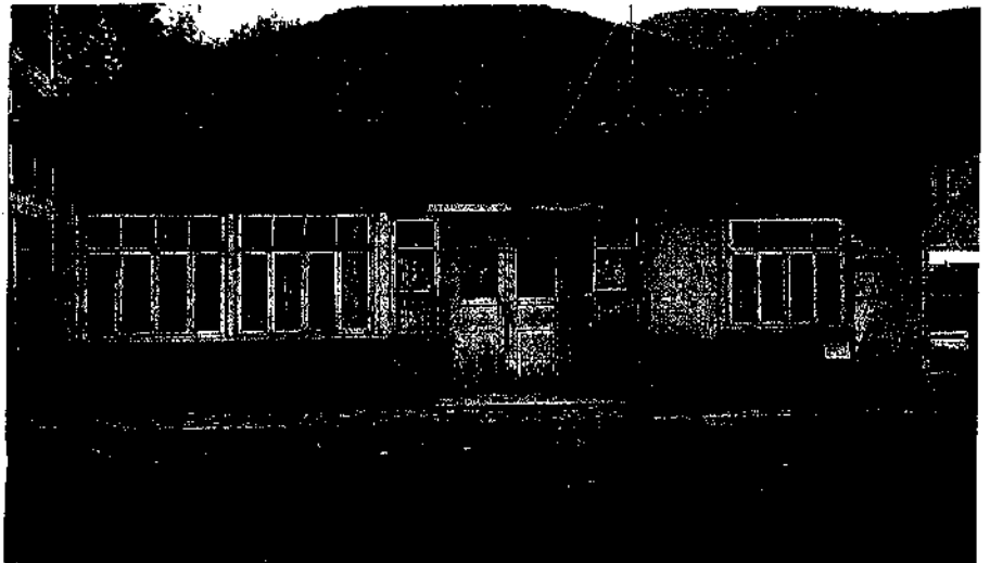
Resim 5. 'Modern' pencereci olarak düşünölen, tuğla dolgu duvarlı ahşap çatki yapı, Gölyaka.
