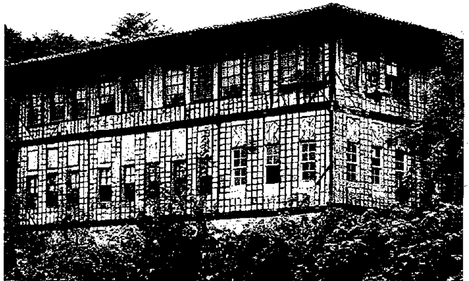
Resim 11. Mimari kültüründen bir örnek: Modüler pencere açıklıkları ve göz dolması, Konak, Rize (Eldem, tarihsiz, 190).
