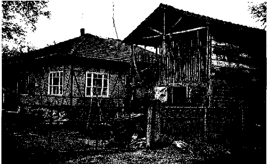
Resim 13. Betonarme kolonlar üzerindeki depo seranderin büyük ölçüde yozlaşığı görülüyor, Gölyaka.
