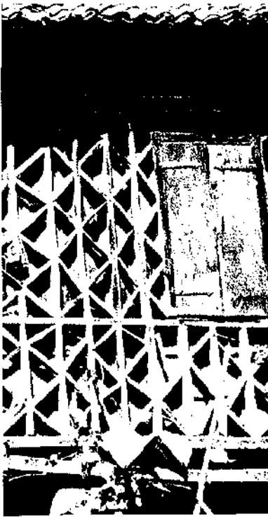
Resim 12. Muskalı duvar çatkısı, Sürmene (Eldem, tarihsiz, 188).
