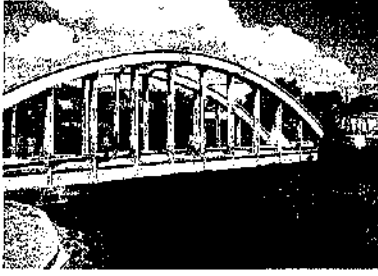
Resim 5. Silahtar Köprüsü; diğer adıyla Fil Köprüsü; Ağustos 2001.
